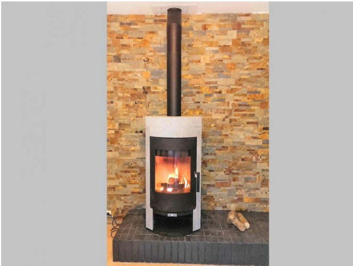
*Installation d'un poêle à bois Rika Imposa avec système Rikatronic gérant l'arrivée d'air en fonction de la température intérieure du corps de chauffe assurant ainsi une parfaite combustion et une économie de bois.*
