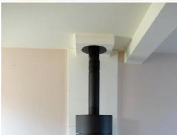
*Installation d'un poêle à Bois Scan 85 raccordé sur un conduit Poujoulat existant.*
