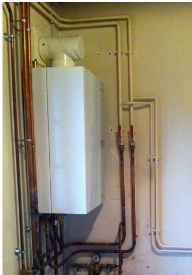
*Installation d'une chaudière gaz à condensation Weishaupt et d'un ballon solaire avec deux capteurs en sur toiture pour l'eau chaude sanitaire*
