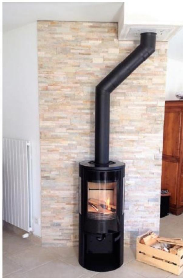
*Au préalable d'une installation d'un poêle à bois, nous avons remplacé le Placo par une plaque de Glasroc classé Mo et de la laine de roche. Nous avons installé dans la cloison une arrivée d'air canalisée venant de l'extérieur de la maison. Sur le mur ainsi refait nous avons posé un revêtement en pierre naturelle . Il ne reste plus qu'à installer le poêle en le raccordant sur un conduit isolé flexible passé dans un boisseau en terre cuite.*
