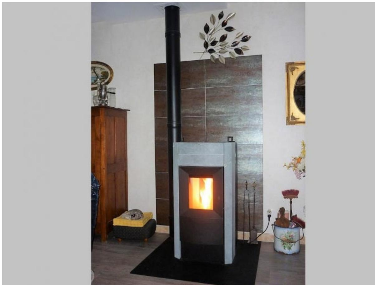
*Installation d'un poele à granulés Rika Revo d'une puissance de 9 Kw avec sortie sur le côté .*
