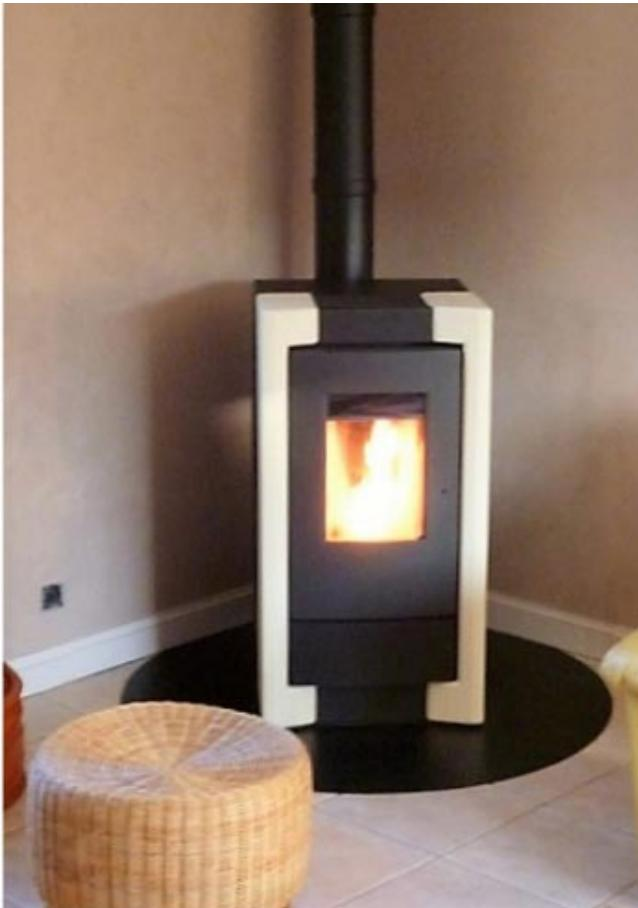
*Réalisation d'une installation d'un poêle à granulés Rika Como d'une puissance de 9 kw avec régulation en fonction de la température d'ambiance à l'aide d'une sonde sans fil.*
