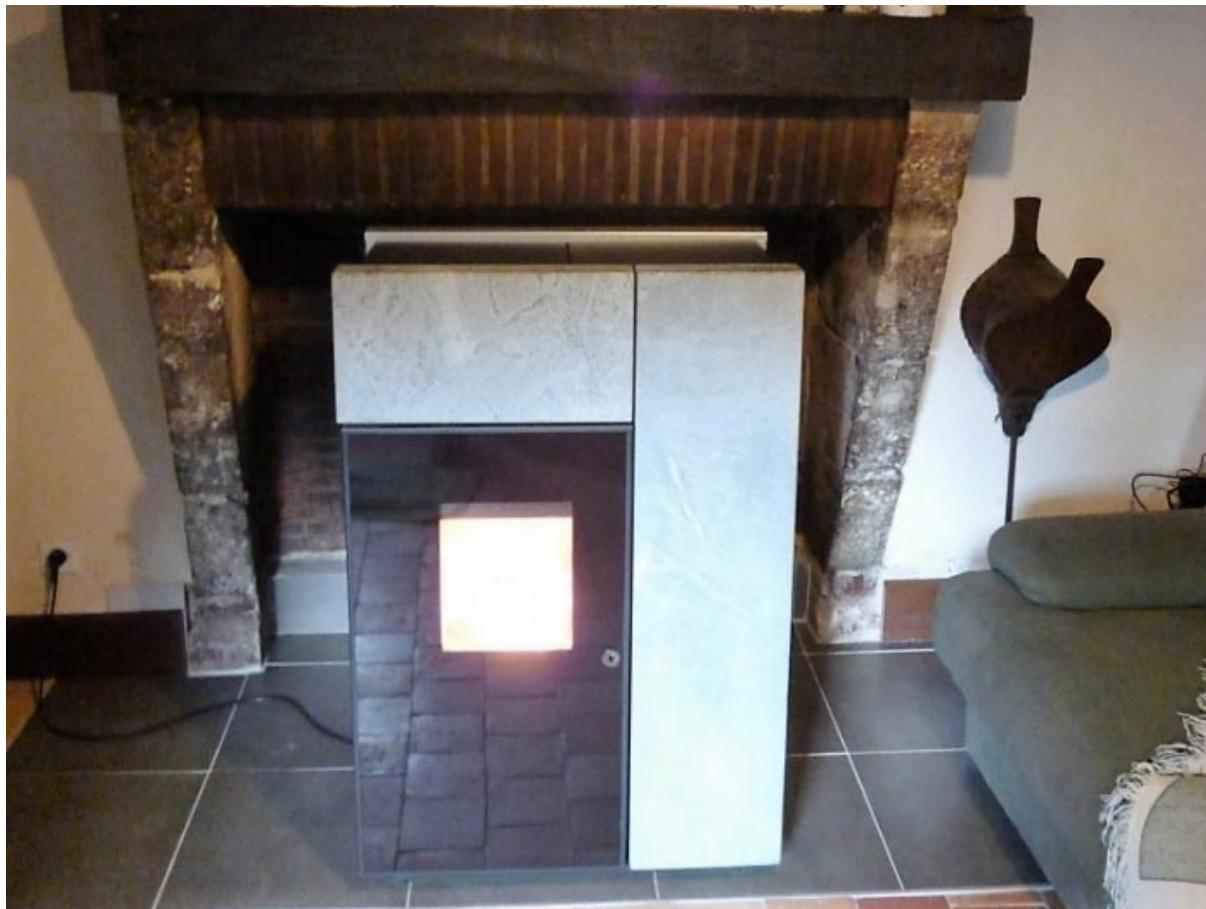
*Installation d'un poêle à granulés Rika Topo avec déclenchement automatique et régulation avec thermostat sans fil.*
