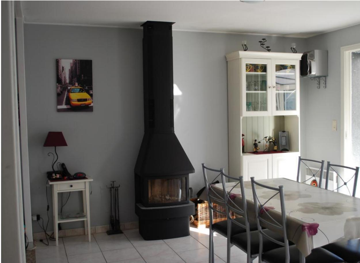
*Installation d'un poêle à bois Contura 450 avec colonne télescopique, d'une puissance de 9 kw.*
