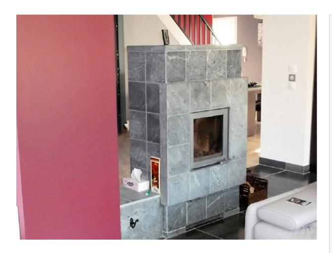
Installation d'un poêle de masse en pierre stéatite Tulikivi Louhi dans le loiret à la Ferté st Aubin. Un poêle de masse permet de chauffer pendant de longues heures après l'arrêt de la combustion. La pierre le constituant accumule la chaleur et peut la restituée pendant une vingtaine d'heure après la fin de la combustion.
