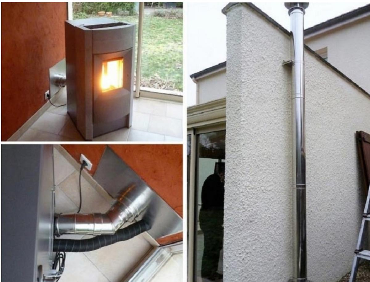
*Installation d'un poêle à granulés RIKA Revo d'une puissance de 9 kW pour chauffer une véranda et le salon de la maison. Le poêle possède une régulation avec thermostat sans fil. Un conduit isolé Poujoulat Therminox a été installé pour l'évacuation des fumées. Une arrivée d'air canalisée venant de l'extérieur est raccordée sur le poêle.*
