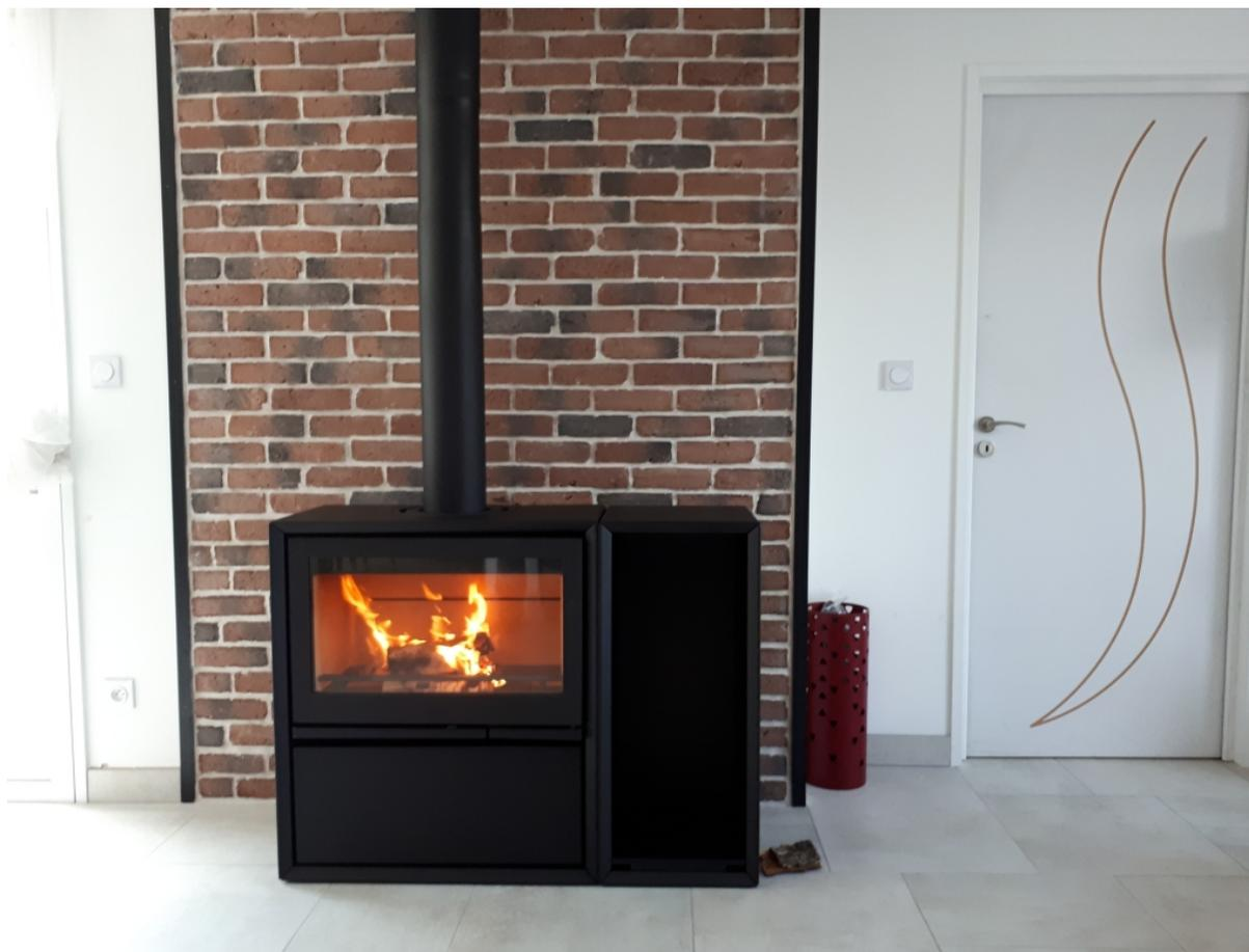
*Installation d'un poêle à bois Contura 310, avec compartiment bois et raccordé à un conduit Poujoulat isolé. L'arrivée d'air de combustion passe par le vide sanitaire et ressort à l'extérieur de la maison. Ce poêle suédois à une puissance de 2 à 7 kW, son rendement de 80% lui permet d'être éligible au crédit d'impôt.*
